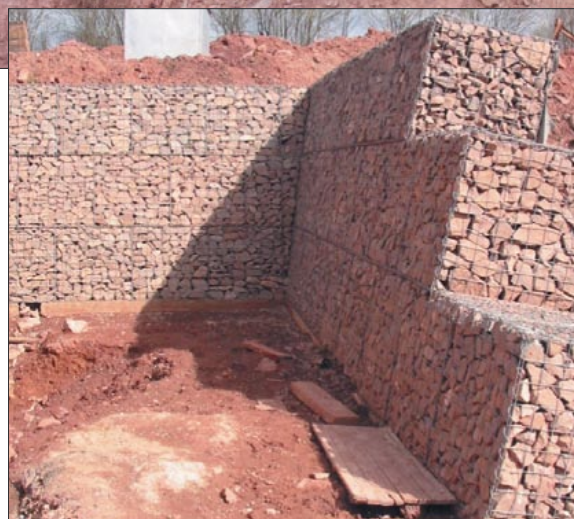
REALIZACE GABIONŮ PRŮMSTAV TRUTNOV s. r. o.
